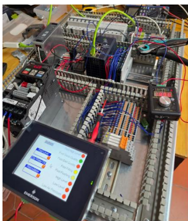
Figura 3. Gabinete eléctrico en proceso de conexión.
